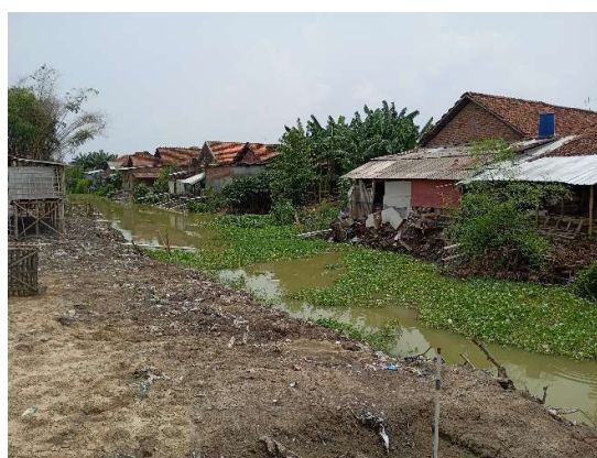
Gambar 2. Kondisi Sungai setelah dilakukan pengerukan
