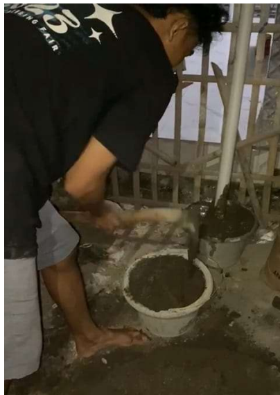
Gambar 7. Pengecoran Rambu Jalan
