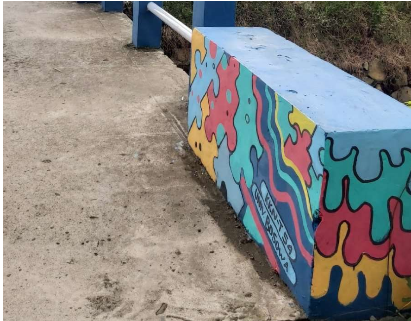
Gambar 3. Pengecatan Jembatan dan Jalan Masuk Menuju Pantai Laguna
