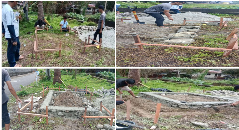
Gambar 2. Pengerjaan Pondasi di lokasi Pengabdian
