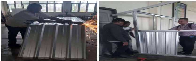
Gambar 3. Pengerjaan Proyek di Politeknik Negeri Ambon
