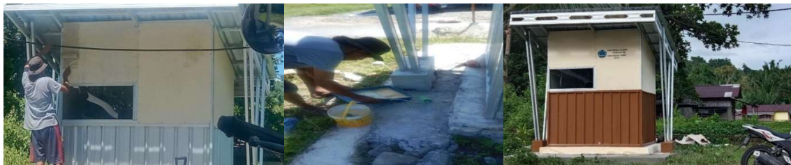
Gambar 5. Pengerjaan Pengecatan & Hasil Proyek
