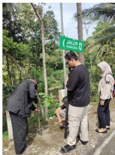
Gambar 5. Pemasangan Plang Jalur Evakuasi
