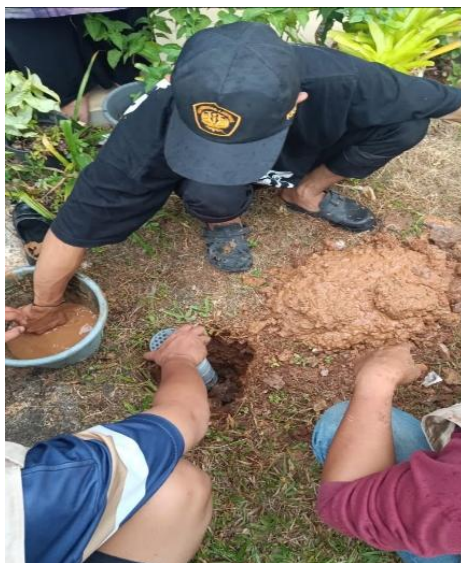
Gambar 4. Praktik Pembuatan Lubang Resapan Biopori
