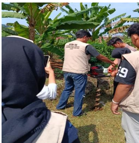
Gambar 3. Praktik Pembuatan Lubang Resapan Biopori
