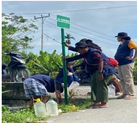
Gambar 3. Penanaman Papan Nama Jalan
