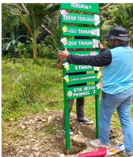
Gambar 3. Pemasangan Papan Edukasi
