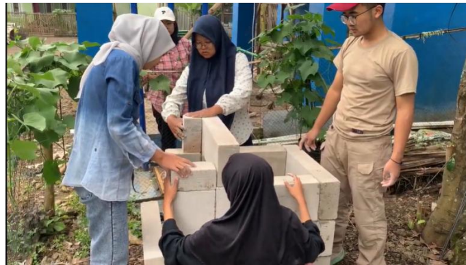
Gambar 1. Proses Pembangunan Insinerator Ramah Lingkungan (INSERA)
