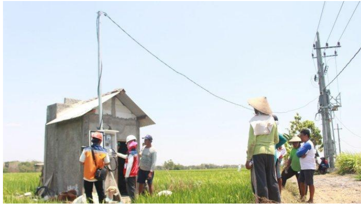
Gambar 2. Pemasangan Jalur Listrik di Kawasan sawah
