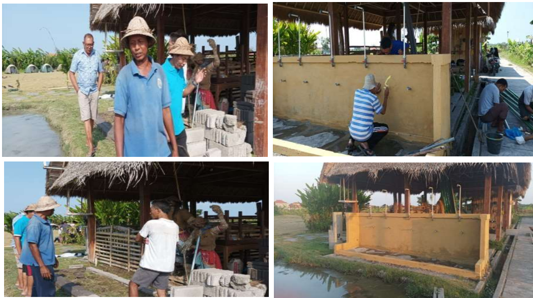
Gambar 4. Pemasangan instalasi air bersih dengan mitra dan mahasiswa
