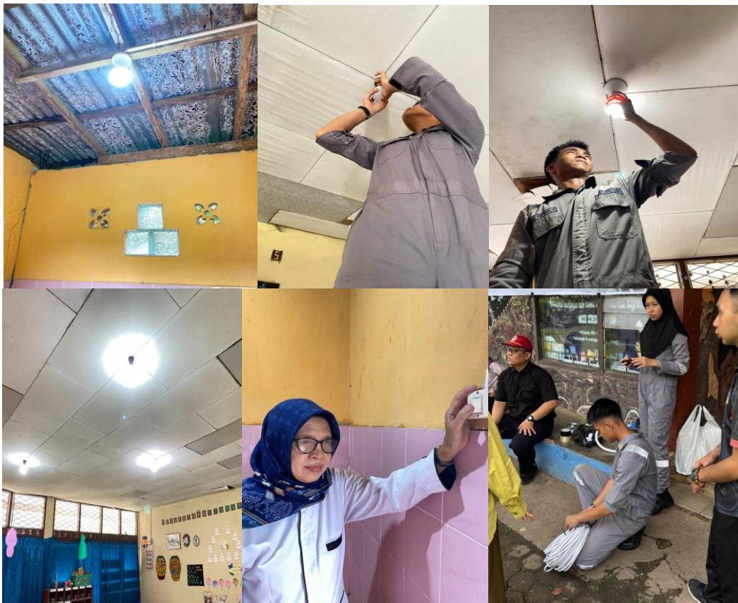
Gambar 4. Hasil Instalasi Listrik yang telah Terpasang
