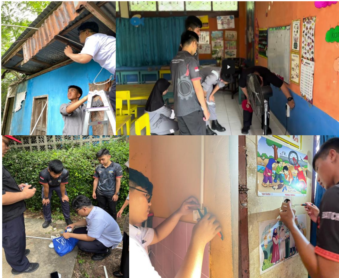
Gambar 3. Proses Pemasangan Instalasi Listrik
