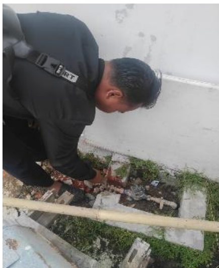
Gambar 3. Pemasangan sambungan baru
