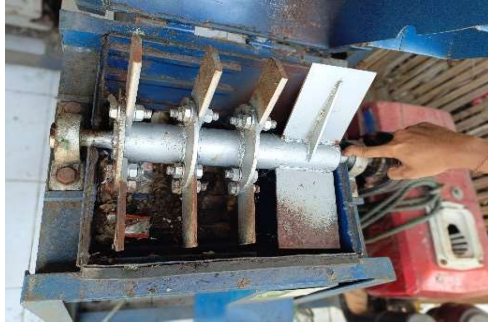
Gambar 5. Kerusakan poros dan pulley
