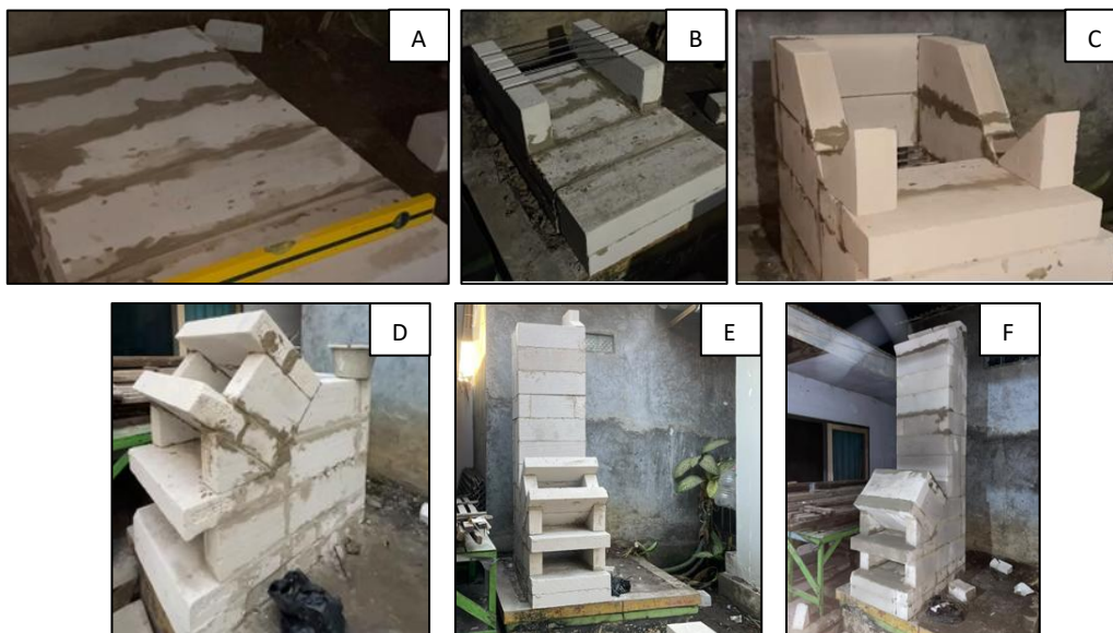
Gambar 2. Dokumentasi tahapan pembangunan insinerator, meliputi (A) pembuatan rata dasar, (B) pemasangan rangka besi, (C) pembuatan penyangga mulut pembakaran dan mulut insinerator, (D) dan (E) pembuatan cerobong, dan (F) hasil akhir pembangunan insinerator.
