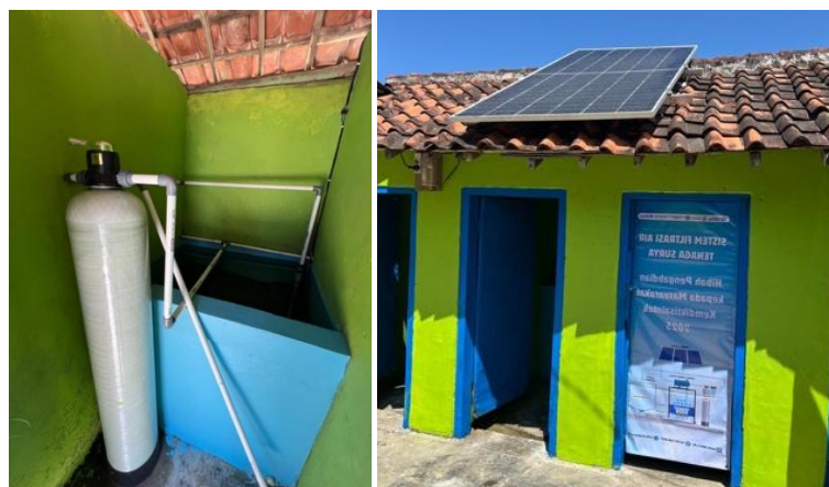
Gambar 5. Kondisi sistem pompa air tenaga surya setelah selesai dipasang
