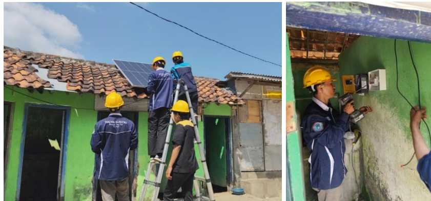
Gambar 3. Proses pemasangan panel surya.
