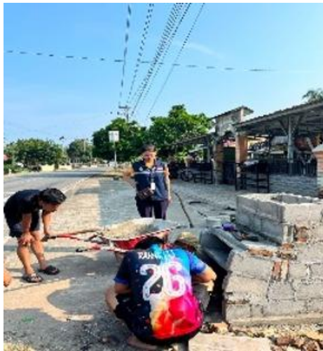
Gambar 2. Proses Pemasangan fondasi dan Pembuatan ruang bakar
