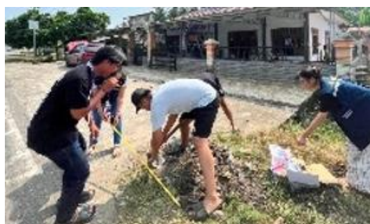
Gambar 1. Persiapan Lokasi Insinerator Sampah
