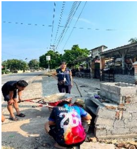
Gambar 2. Proses Pemasangan fondasi dan Pembuatan ruang bakar
