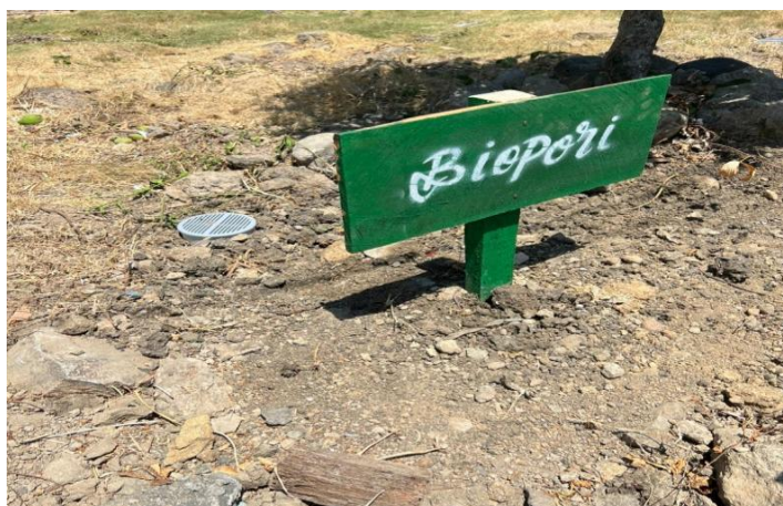
Gambar 2. Pemasangan LRB di Balai Desa Sidokumpul
