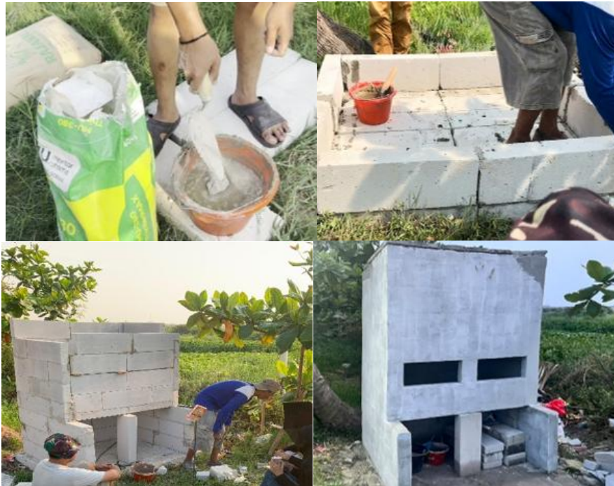
Gambar 3. Proses Perakitan dan Pengelasan Rocket Stove
