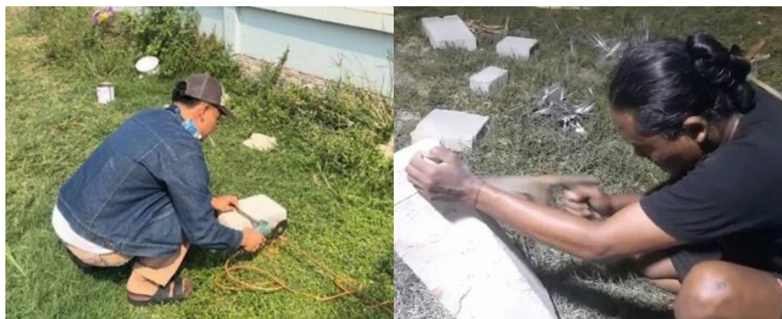
Gambar 2. Proses Pengukuran dan Pemotongan Bahan
