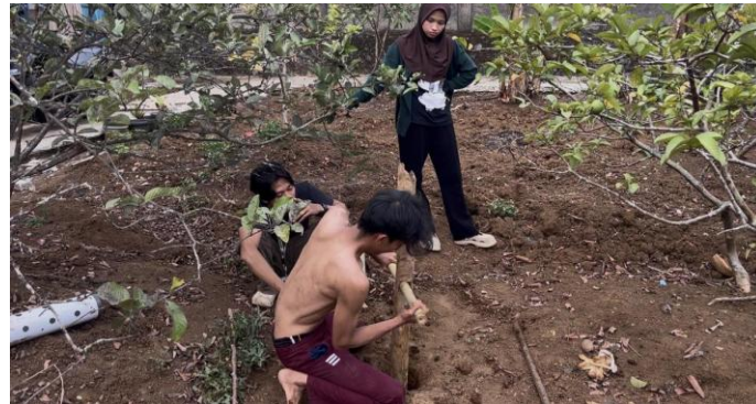
Gambar 4. Praktik Pembuatan Lubang Resapan Biopori Menggunakan Pipa
