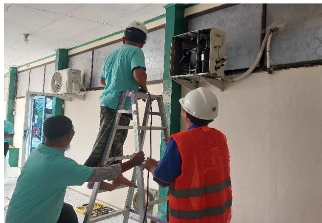
Gambar 4. Praktik Pemeliharaan AC Split dengan Pendampingan Instruktur.
