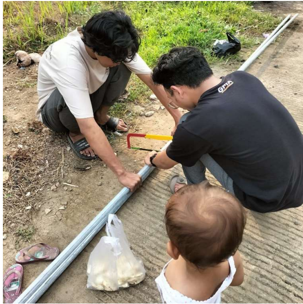
Gambar 2. Pemotongan tiang lampu
