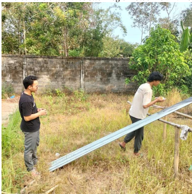
Gambar 1. Pengecatan tiang lampu
